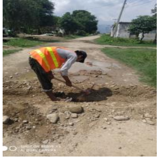
जिर्ण सडक मर्मत-तिलोत्तमा नगरपालिका-१२, रुपन्देही
