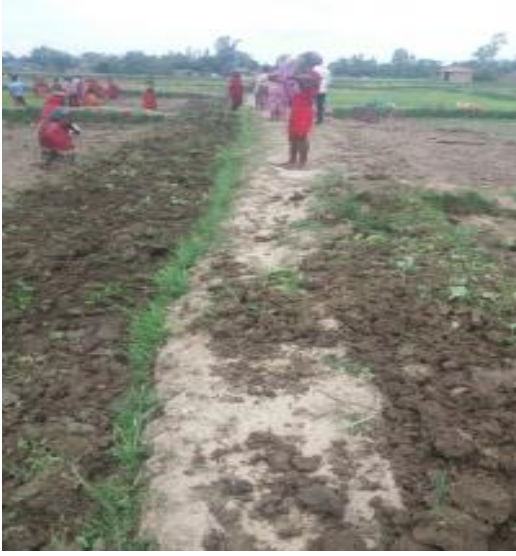
नयाँ कृषि सडक निर्माण-विष्णुपुर गाउँपालिका, सिराहा
