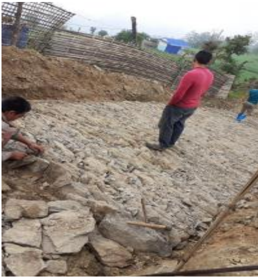
सडक मर्मत-ऐसेलुखर्क गाउँपालिका, खोटाङ
