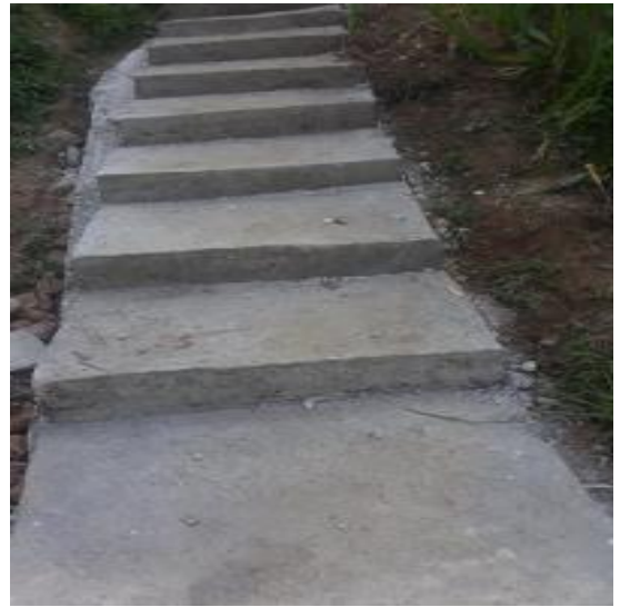
पैदल मार्ग निर्माण-गण्डकी गाउँपालिका, गोरखा
