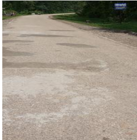
बाटो निर्माण तथा मर्मत-हुप्सेकोट गाउँपालिका, नवलपरासी पूर्व
