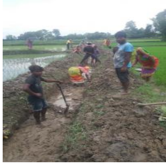
सरसफाई र पैनी निर्माण-विष्णुपुर गाउँपालिका, सिराहा
