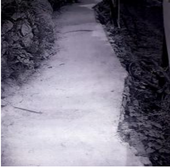
सडक निर्माण-तिलागुफा नगरपालिका, कालिकोट
