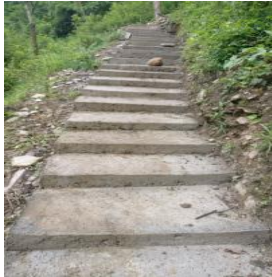
पैदल मार्ग निर्माण-गण्डकी गाउँपालिका, गोरखा
