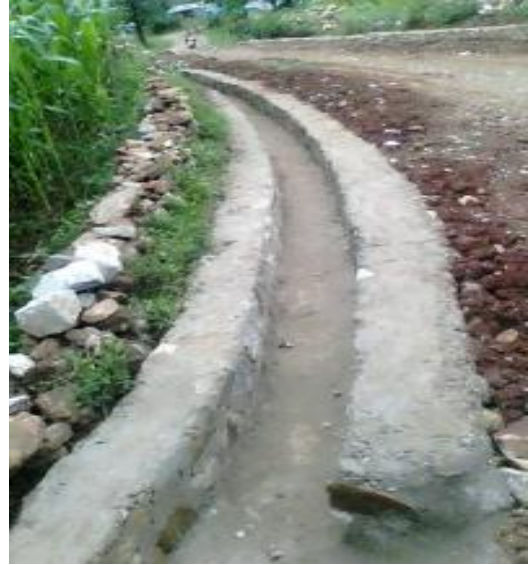
पक्की नाला निर्माण-गण्डकी गाउँपालिका, गोरखा
