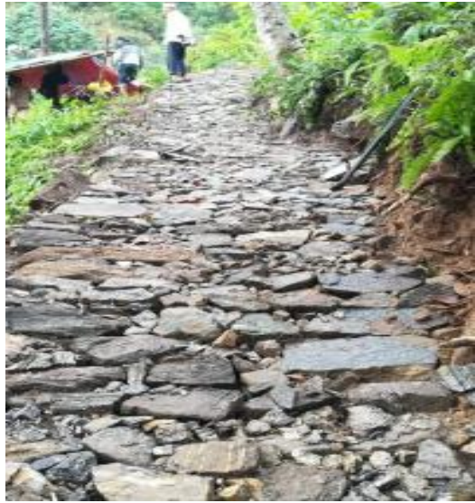
गोरेटो बाटो निर्माण-महालक्ष्मी नगरपालिका, धनकुटा
