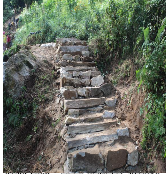
पदमार्ग निर्माण - चिचिला गाउँपालिका, संखुवासभा
