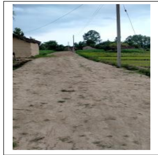
सडक निर्माण तथा स्तरोन्नती-लालझाडी गाउँपालिका, कञ्चनपुर
