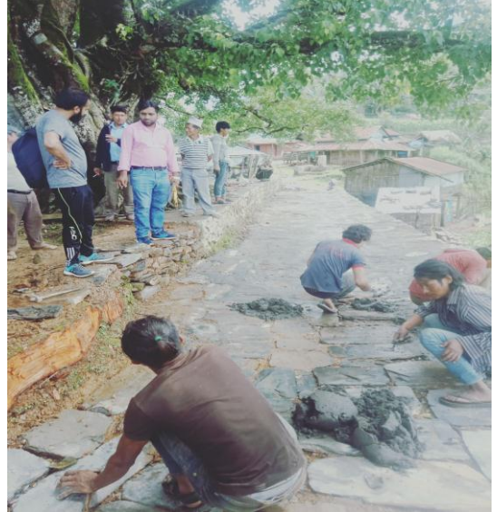
पदमार्ग निर्माण-देवघाट गाउँपालिका-४, तनहुँ
