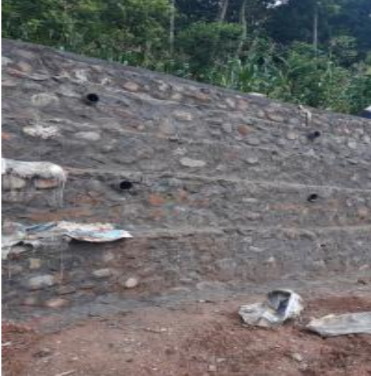
सिचाई निर्माण-लिखु गाउँपालिका-५, नुवाकोट
