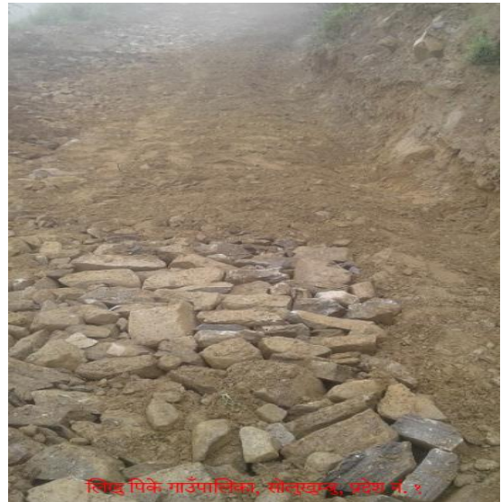
सडक सोलिड-लिखु पिके गाउँपालिका-५, सोलुखुम्बु
