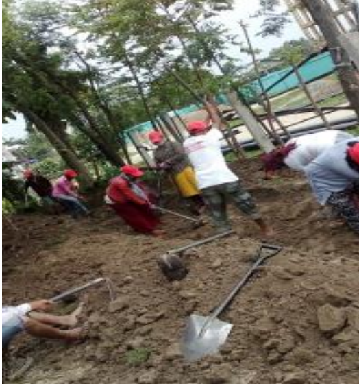
खानेपानी पाइप लाइन विस्तार-रामधुनी नगरपालिका, सुनसरी
