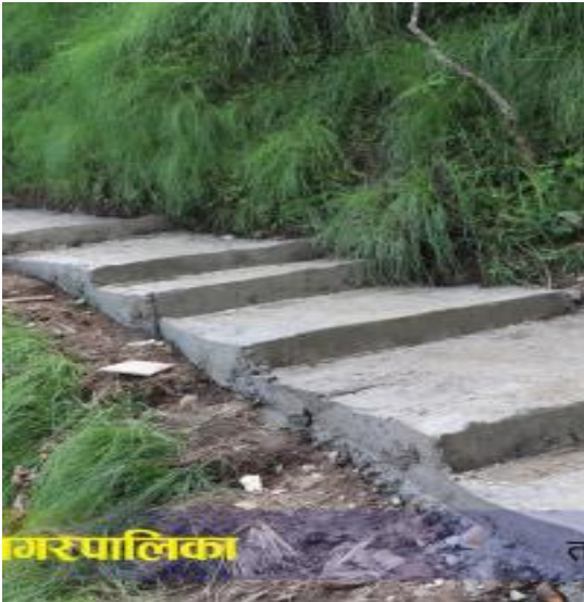
पदमार्ग निर्माण-भीरकोट नगरपालिका-६, स्याङ्जा
