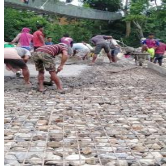
सडक सोलिड-तीनपाटन गाउँपालिका, सिन्धुली
