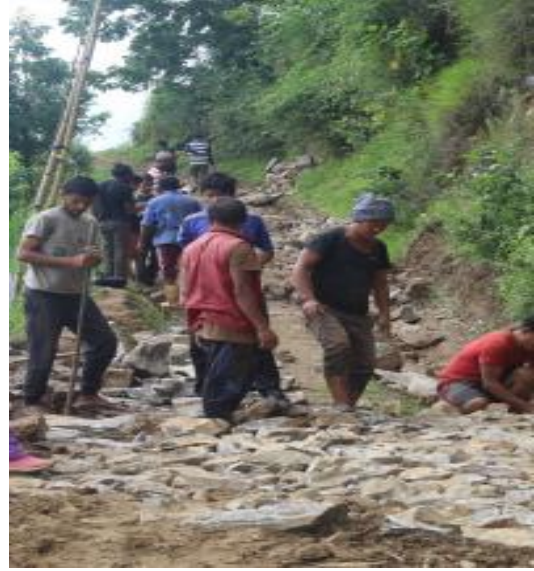
सडक निर्माण-फालेलुङ गाउँपालिका, पाँचथर
