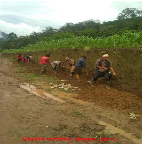
कुलो तथा नाली निर्माण-लिखु पिके गाउँपालिका-३, सोलुखुम्बु
