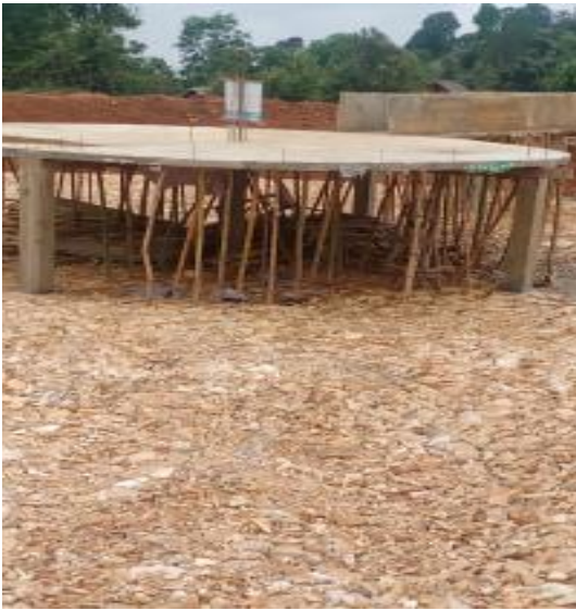
बहुउद्देश्यीय सिचाई पोखरी निर्माण-माडी गाउँपालिका-५, रोल्पा
