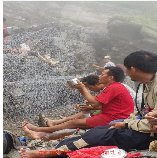
सडक तार जाली निर्माण-रोड गाउँपालिका-६, इलाम
