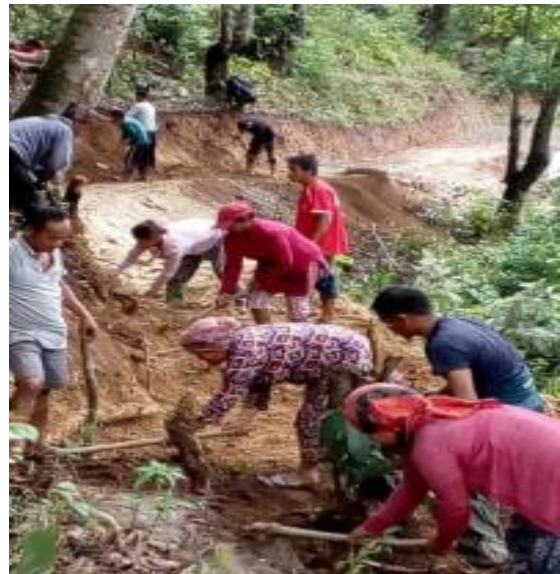
सडक स्तरोन्नती-छथर जोरपाटी गाउँपालिका-१, धनकुटा
