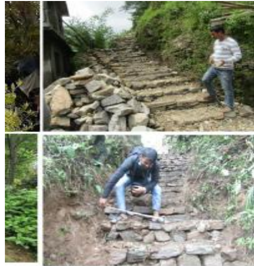
पद मार्ग निर्माण - मेलम्ची नगरपालिका-४, सिन्धुपाल्चोक
