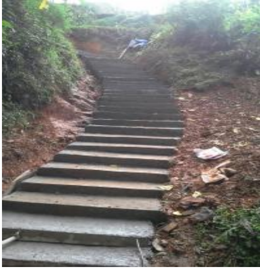
सिढी निर्माण-जैमिनी नगरपालिका, बागलुङ
