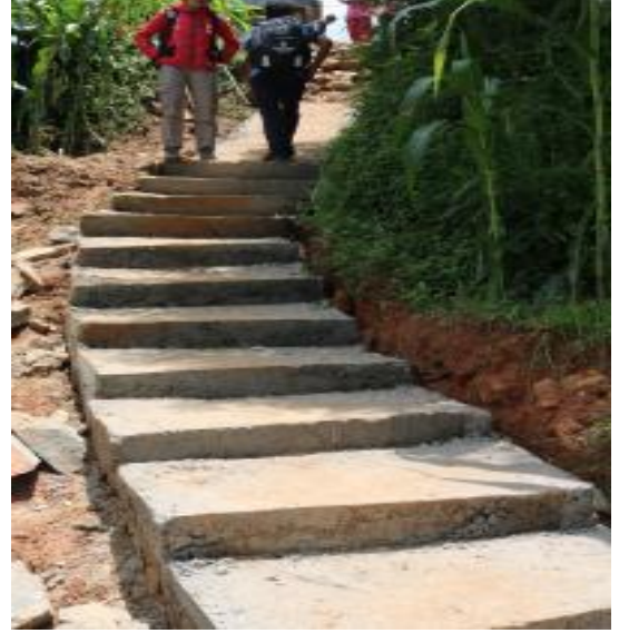
पदमार्ग निर्माण-गण्डकी गाउँपालिका, गोरखा
