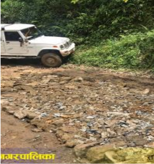
कुलो निर्माण तथा बाटो मर्मत-भीरकोट नगरपालिका-६, स्याङ्जा
