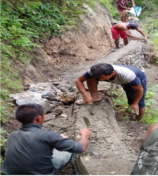
सिचाई कुलो मर्मत-देवघाट गाउँपालिका-१, तनहुँ
