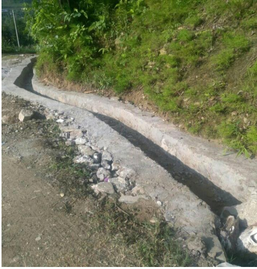
कुलो निर्माण-सुनकोशी गाउँपालिका-३, सिन्धुपाल्चोक
