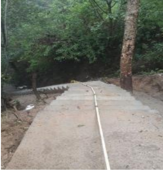
पदमार्ग निर्माण-मण्डनदेउपुर गाउँपालिका, काभ्रेपाल्चोक
