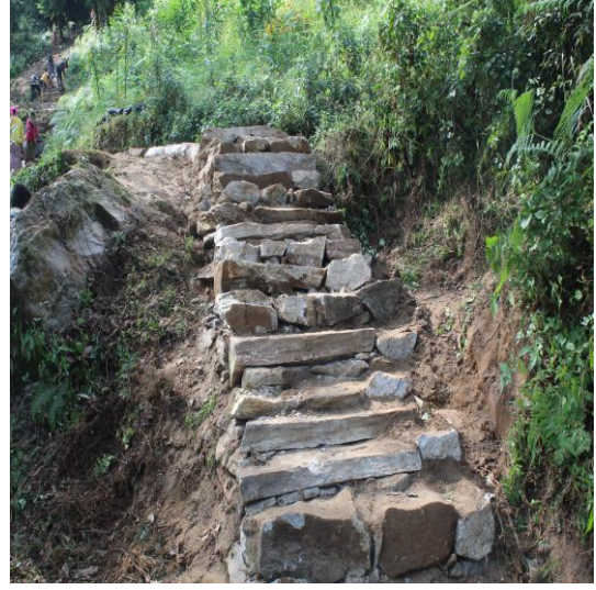
पदमार्ग निर्माण - चिचिला गाउँपालिका, संखुवासभा
