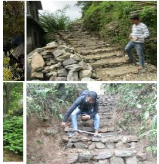
पद मार्ग निर्माण - मेलम्ची नगरपालिका-४, सिन्धुपाल्चोक
