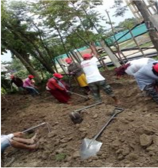
खानेपानी पाइप लाइन विस्तार-रामधुनी नगरपालिका, सुनसरी
