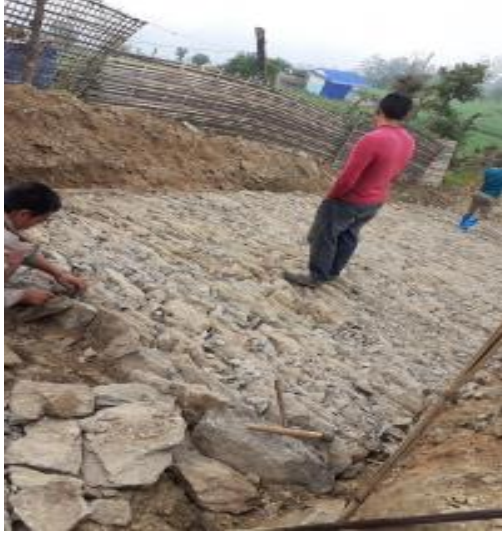
सडक मर्मत-ऐसेलुखर्क गाउँपालिका, खोटाङ
