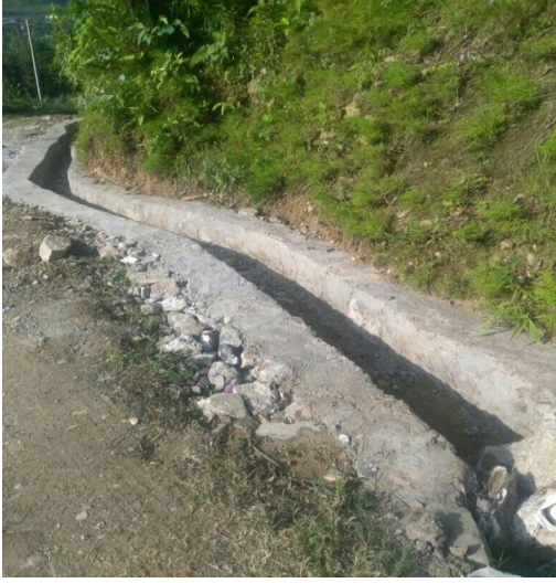
कुलो निर्माण-सुनकोशी गाउँपालिका-३, सिन्धुपाल्चोक
