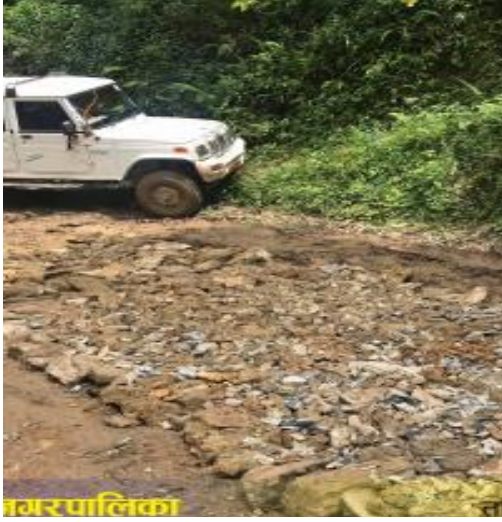
कुलो निर्माण तथा बाटो मर्मत-भीरकोट नगरपालिका-६, स्याङ्जा
