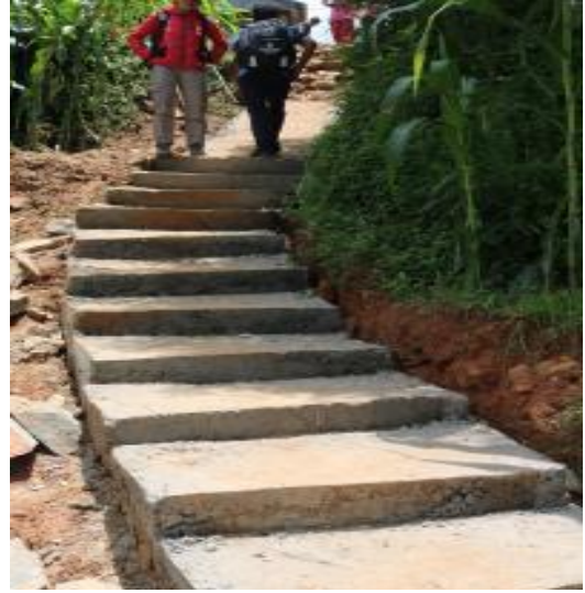
पदमार्ग निर्माण-गण्डकी गाउँपालिका, गोरखा
