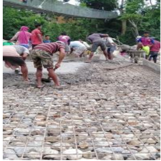
सडक सोलिड-तीनपाटन गाउँपालिका, सिन्धुली
