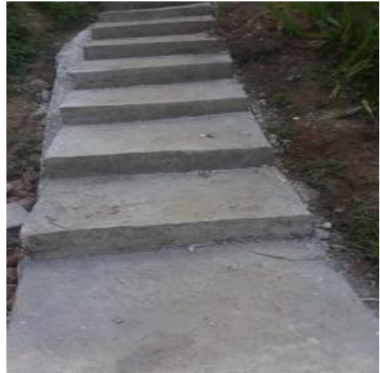
पैदल मार्ग निर्माण-गण्डकी गाउँपालिका, गोरखा
