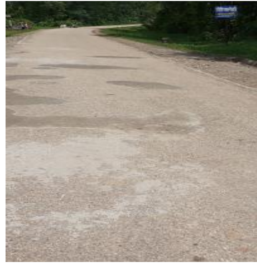
बाटो निर्माण तथा मर्मत-हुप्सेकोट गाउँपालिका, नवलपरासी पूर्व
