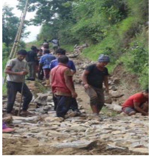
सडक निर्माण-फालेलुङ गाउँपालिका, पाँचथर
