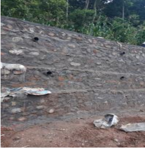
सिचाई निर्माण-लिखु गाउँपालिका-५, नुवाकोट
