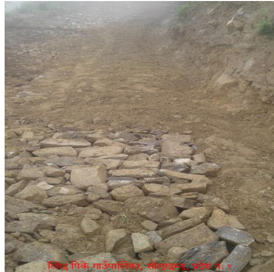
सडक सोलिड-लिखु पिके गाउँपालिका-५, सोलुखुम्बु
