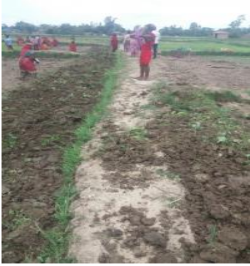
नयाँ कृषि सडक निर्माण-विष्णुपुर गाउँपालिका, सिराहा
