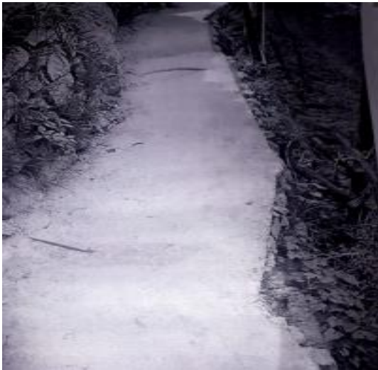
सडक निर्माण-तिलागुफा नगरपालिका, कालिकोट
