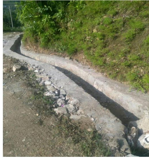
कुलो निर्माण-सुनकोशी गाउँपालिका-३, सिन्धुपाल्चोक
