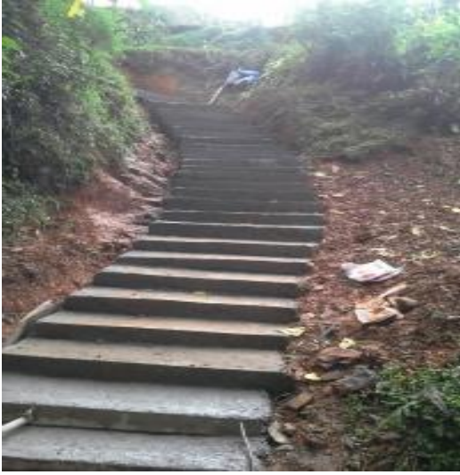
सिढी निर्माण-जैमिनी नगरपालिका, बागलुङ
