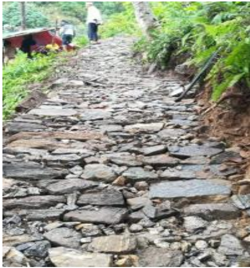
गोरेटो बाटो निर्माण-महालक्ष्मी नगरपालिका, धनकुटा
