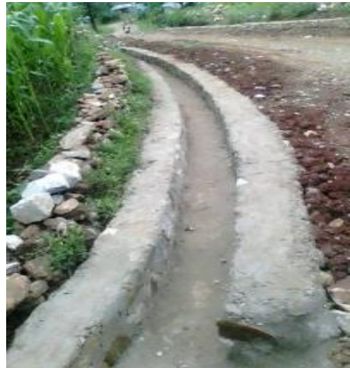
पक्की नाला निर्माण-गण्डकी गाउँपालिका, गोरखा
