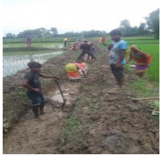
सरसफाई र पैनी निर्माण-विष्णुपुर गाउँपालिका, सिराहा
