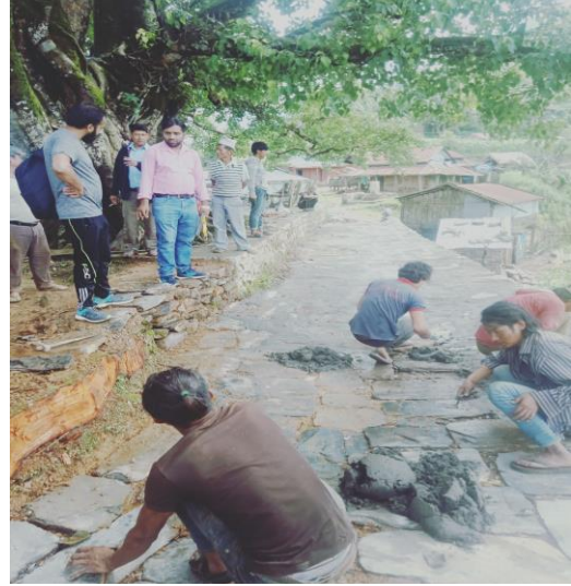
पदमार्ग निर्माण-देवघाट गाउँपालिका-४, तनहुँ
