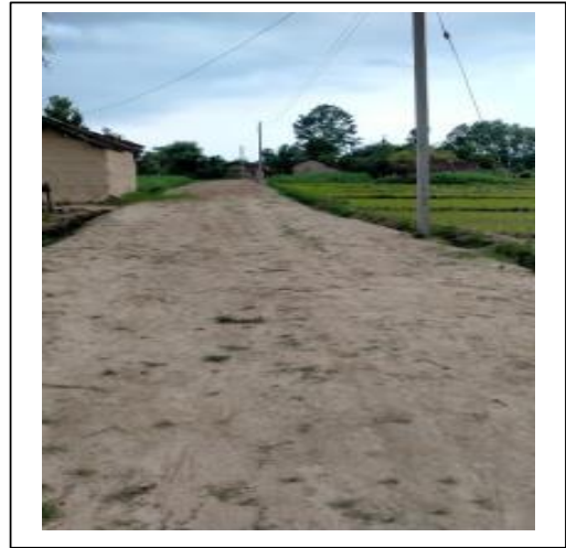
सडक निर्माण तथा स्तरोन्नती-लालझाडी गाउँपालिका, कञ्चनपुर
