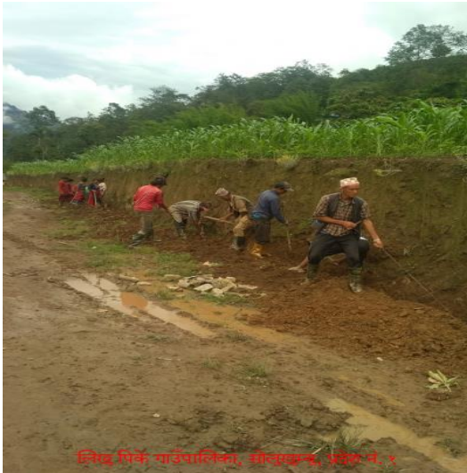
कुलो तथा नाली निर्माण-लिखु पिके गाउँपालिका-३, सोलुखुम्बु
