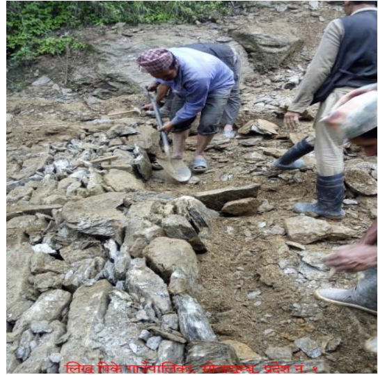
सडक सोलिड-लिखु पिके गाउँपालिका-१, सोलुखुम्बु
