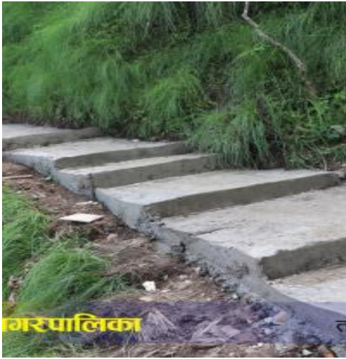
पदमार्ग निर्माण-भीरकोट नगरपालिका-६, स्याङ्जा
