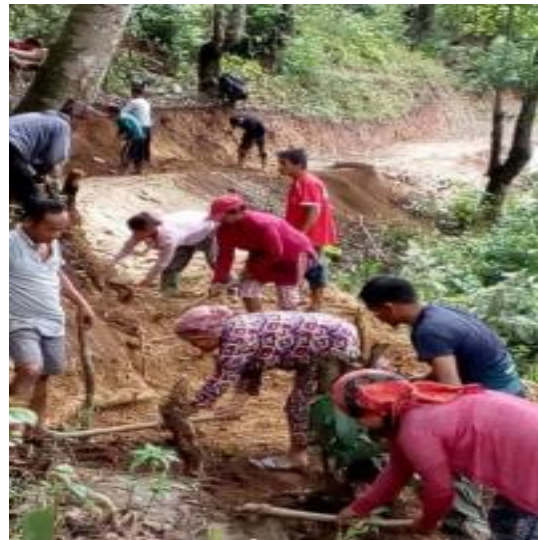
सडक स्तरोन्नती-छथर जोरपाटी गाउँपालिका-१, धनकुटा
