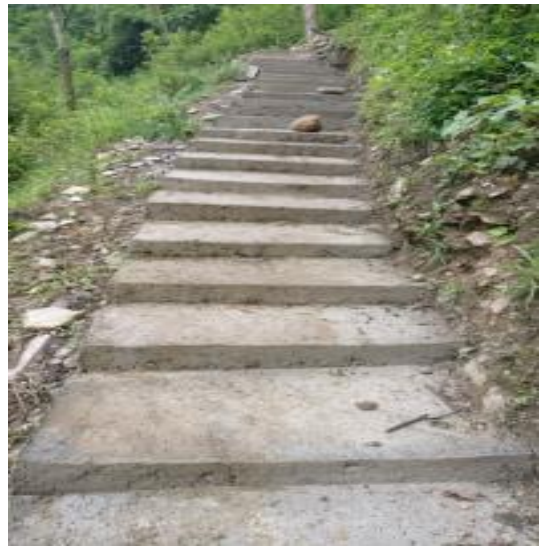
पैदल मार्ग निर्माण-गण्डकी गाउँपालिका, गोरखा
