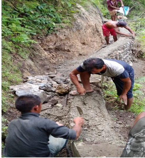
सिचाई कुलो मर्मत-देवघाट गाउँपालिका-१, तनहुँ
