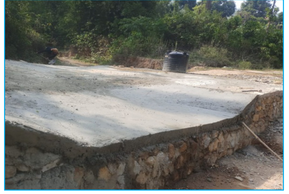
तानसेन नगरपालिका भल्व व्यवस्थापन तथा खानेपानी धारा निर्माण
