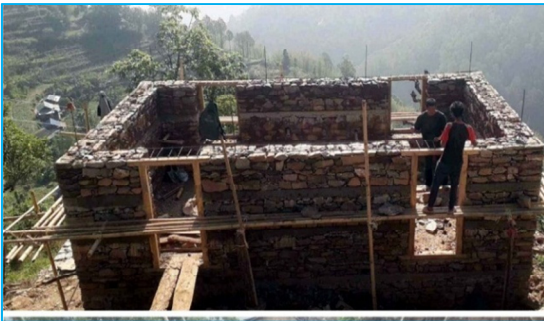
सामुदायिक भवन निर्माण साविक ५ रामप्रसादराई गा.पा. वडा नं. ६, बैकुण्ठे
