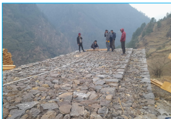
तटबन्ध निर्माण, चुमनुव्री गाउँपालिका, गारेखा
