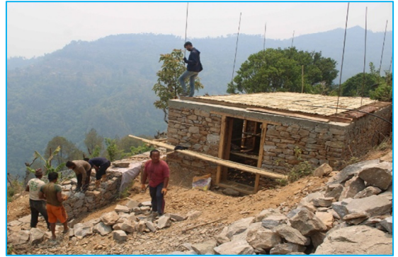
सामुदायिक भवन निर्माण साविक ५ रामप्रसादराई गा.पा. वडा नं. ६, बैकुण्ठे
