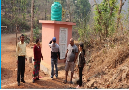
तानसेन नगरपालिका भल्व व्यवस्थापन तथा खानेपानी धारा निर्माण
