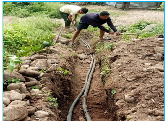
निजगढ नगरपालिका वडा नं. १३ नाला मर्मत तथा खानेपानी पाईपलाईन बिस्तार
