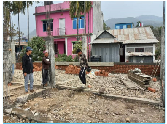
आधारभूत खोपकेन्द्र भवन निर्माण धरान-५
