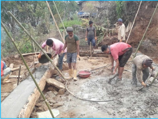
सामुदायिक भवन निर्माण साविक ५ रामप्रसादराई गा.पा. वडा नं. ६, बैकुण्ठे
