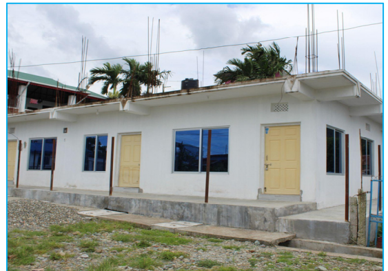
आधारभूत खोपकेन्द्र भवन निर्माण धरान-५
