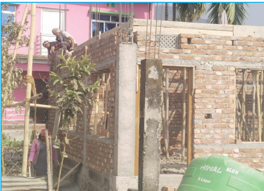
आधारभूत खोपकेन्द्र भवन निर्माण धरान-५
